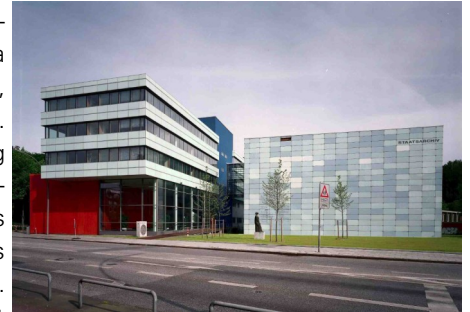
Außenansicht des Staatsarchivs von der Kattunbleiche aus
