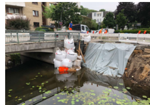
Big Bags stabilisieren vorerst den Pfeiler und die darüberliegende Brücke.
