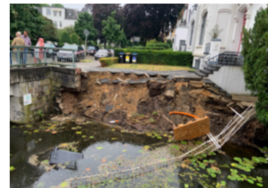
Die abgebrochene Uferwand droht auch den Brückenpfeiler mitzureißen. Das Team muss die Brücke rasch stabilisieren.
