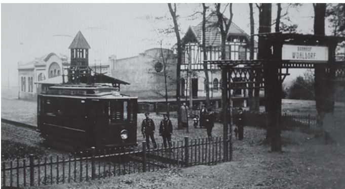
De Bahnhoff Wohldörp. Rechts dat Bahnhofsgebüüd mit een Laderamp. Links mit de Finster de dreesporige Wagenhall.
