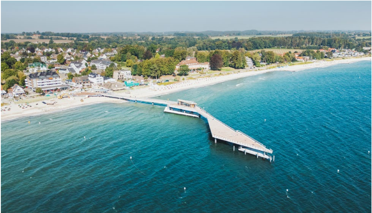
Jetzt fertiggestellt: Die neue Seebrücke von Haffkrug führt im Zickzack hinaus auf die Lübecker Bucht.
