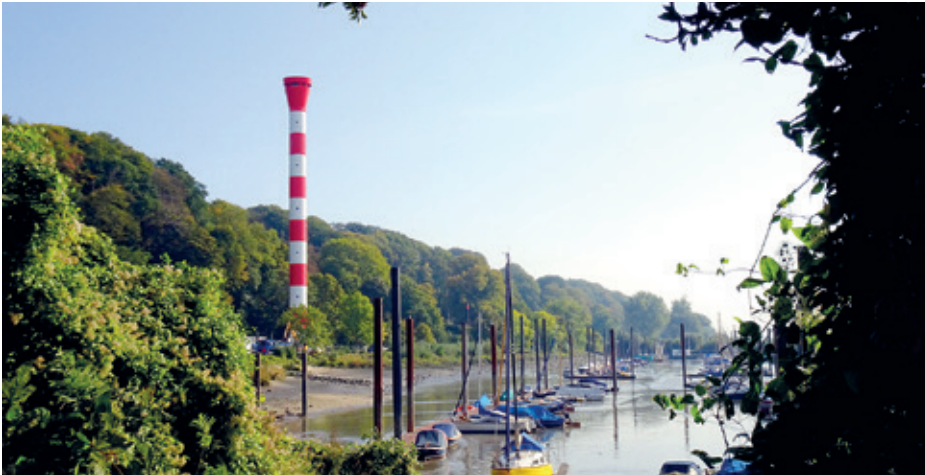
Ein Blick von unten auf den Leuchtturm
