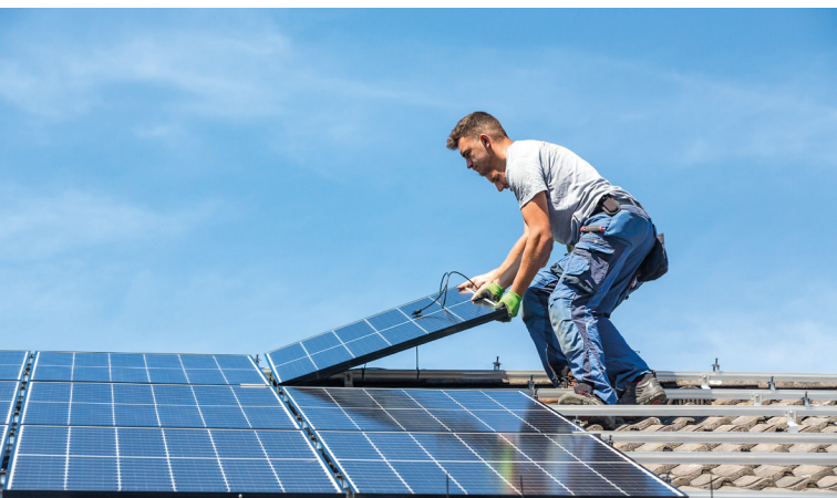
Montage einer Aufdach-Solaranlage.
