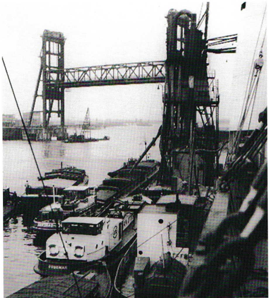
Die alte Rethehubbrücke in gehobenen Zustand.
