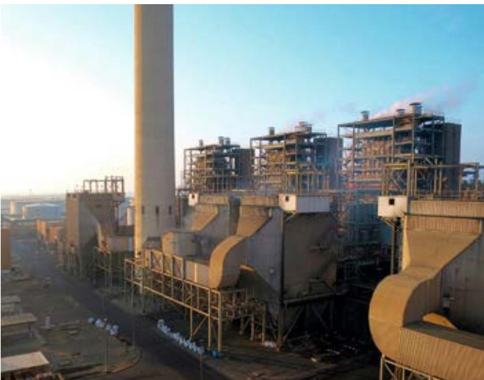
*Am Roten Meer südlich von Dschiddah befinden sich fünf Kraftwerksblöcke und zehn Meerwasserentsalzungsanlagen des Kraftwerks Shoaiba I. Die Entsalzungsanlagen des staatlichen Eigentümers und Betreibers Saline Water Conversion Corporation liefern in die großen Städte Dschiddah, Mekka und Taif täglich 223.000 m<sup>3</sup> Trinkwasser. Zum Betrieb dieser Anlagen werden stündlich 2.000 t Dampf benötigt, der in den ölbefeuerten Kesseln der Kraftwerksblöcke erzeugt wird.*
