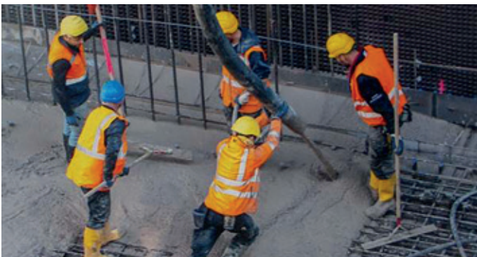
Der Tunnelboden der Haltestelle City Nord (Stadtpark) wird geschüttet.
