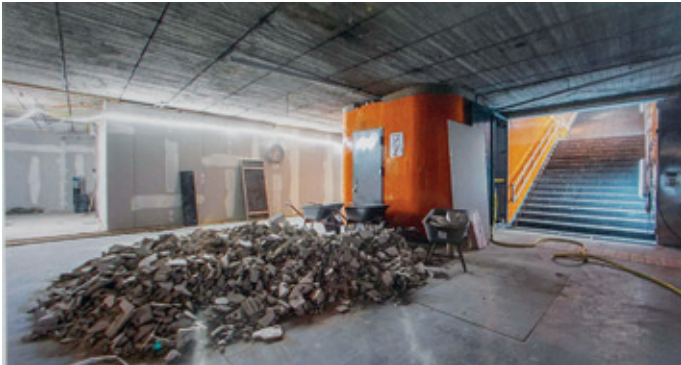
...und die ehemalige Schalterhalle werden in neuem Glanz erscheinen.
