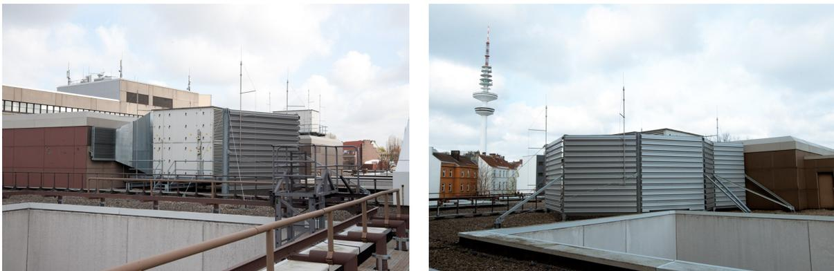
Abb. 74. Das linke Foto zeigt die Klimazentrale 3 auf dem Dach des Hauptgebäudes mit den außen angebauten Anlagen zur Wärmerückgewinnung und rechts davon die Schallschutzwand. Bei der Zentrale 2, die dahinter liegt, wurden die Wärmerückgewinnungsanlagen auf dem Zentralendach aufgestellt. Auf dem rechten Foto ist die gesamte Schallschutzwand unmittelbar neben dem Atrium 3 zu sehen. (Fotos vom 16.04.2015, Dorothea Ahlers, SUB)
