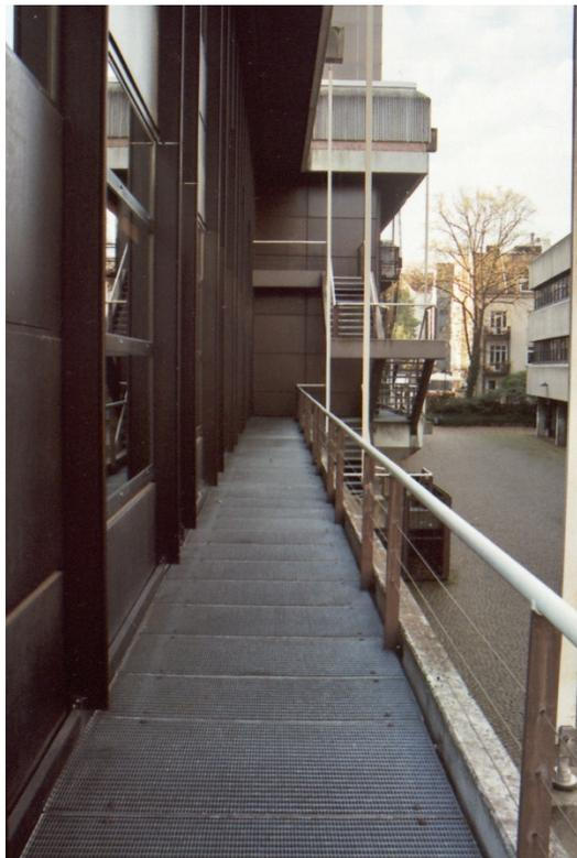
Abb. 41. Fassade des Hauptgebäudes an der Nordwestseite des Gebäudes mit Fluchtbalkon und Fluchttreppenhäuser. Die Gitterroste auf den Laufflächen und den Treppenstufen wurden gewählt, weil bei Glatteis und Schneefall damit weniger Probleme entstehen als bei einer massiven Ausführung. (Foto vom 01.11.2014, Verf.)
