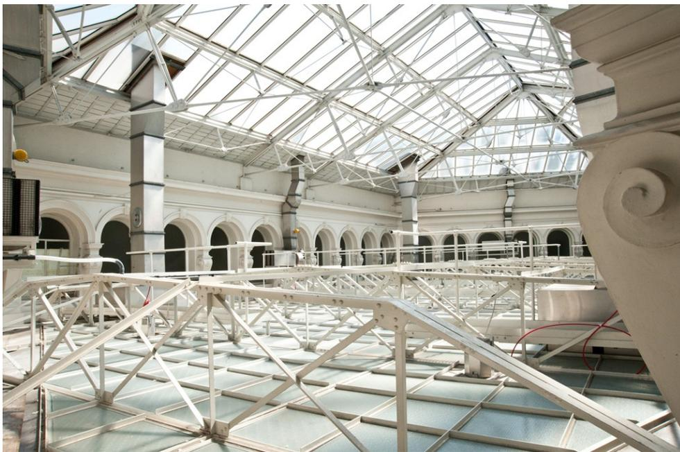
Abb. 62. Raum zwischen Glasdecke und Glasdach im 3. Stock des Altbaus (Foto vom 10.07.2014, Dorothea Ahlers, SUB)
