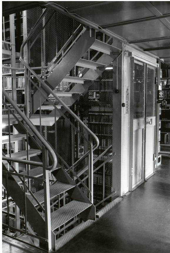
Abb. 58. Treppenhaus sowie Personen- und Lastenaufzug in der 6. Ebene des Altbau-Magazins. Wie dieses Foto zeigt, war das Treppenhaus ursprünglich offen, und der Aufzug war an den Seiten und in den Türöffnungen lediglich durch Maschendraht vom Magazin abgetrennt. (Foto vom Juli 1956, Dr. Erna Knöfel, SUB)
