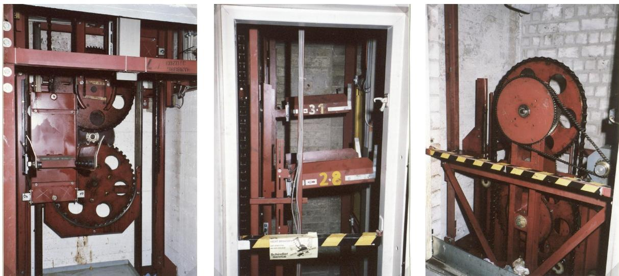
Abb. 49. Umlaufaufzug 3 der Buchkorbförderanlage im Bücherturm. Das linke Foto wurde im 0. Stock, das mittlere im 16. Stock und das rechte im 17. Stock bei geöffneter Schachttür aufgenommen. Das mittlere Foto zeigt zwei „Gehänge“ (mit den Nummern 28 und 31), in die die Behälter (von rechts) eingeladen werden können. (Foto vom Juli 2003, Dieter Jonas, SUB)
