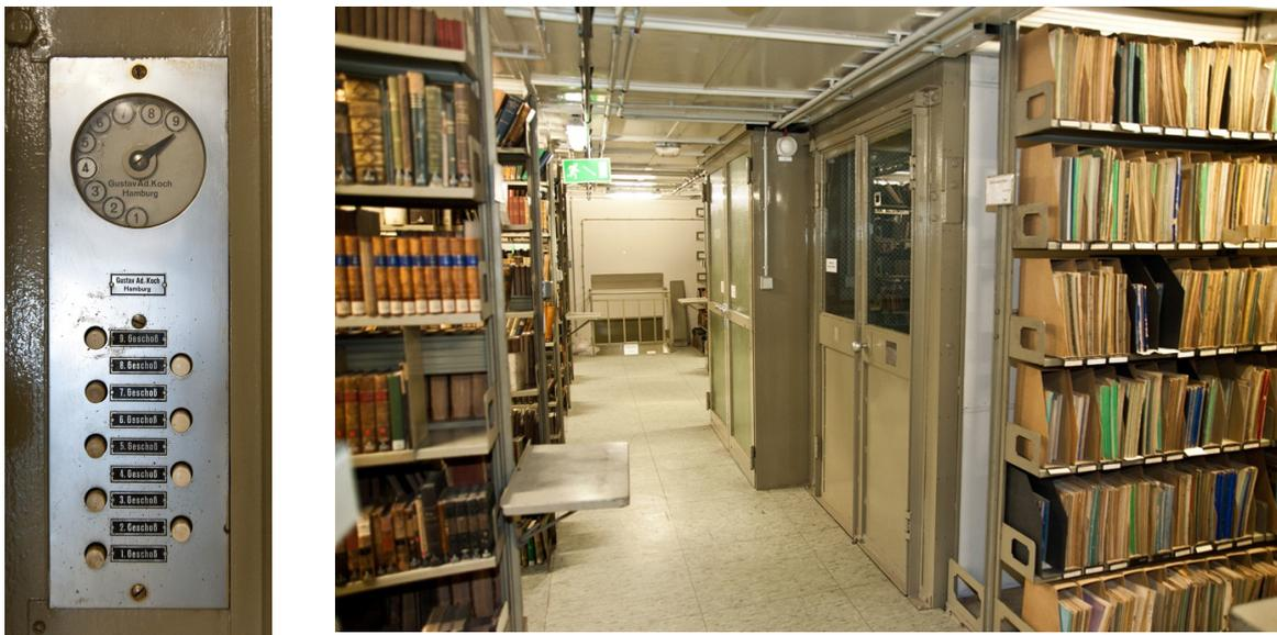
Abb. 11. Linkes Foto: Fahrkorbanzeige und Bedientableau des alten Personen- und Lastenaufzugs (Fa. Koch) im Altbau-Magazin
