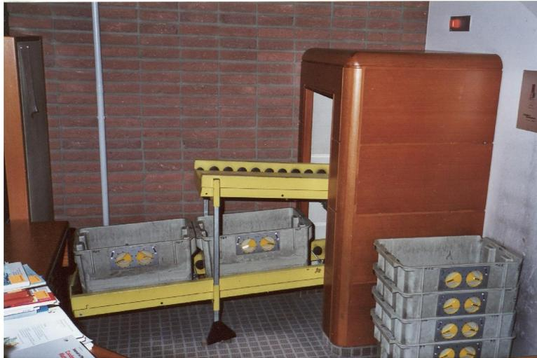
Abb. 46. Station der Buchkorbförderanlage im Lesesaal 2. Auf der oberen Bahn werden die Behälter abgeschickt; die untere Bahn ist die Empfangsbahn. Beide Bahnen sind mit der dahinter liegenden Hubvorrichtung verbunden, die den Abstand zur Horizontaltrasse oberhalb der abgehängten Decke überbrückt. Mit den beiden drehbaren (gelben) Zeigern an der Seite konnte die zweistellige Zieladresse der Behälter eingestellt werden. (Foto vom Juli 2003, Dieter Jonas, SUB)
