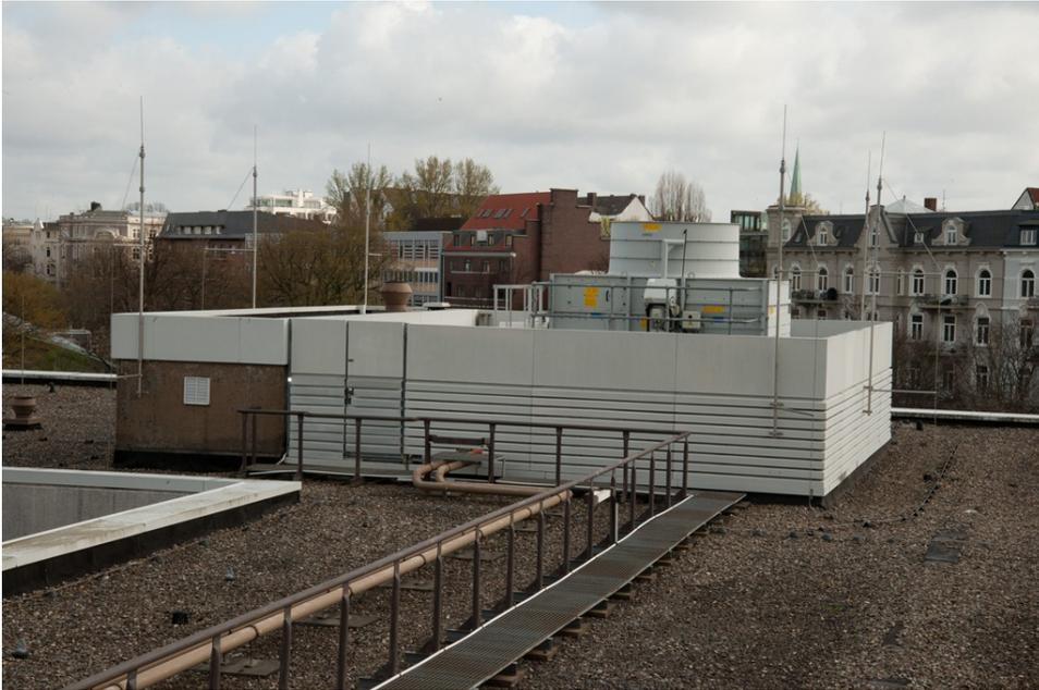
Abb. 75. Der Hybrid-Kühlturm wurde auf dem Dach des Hauptgebäudes an der Stelle aufgestellt, wo vorher der Kühlturm des Hauptgebäudes und das Rückkühlwerk des Bücherturms standen. Links daneben liegt der Maschinenraum des Aufzugs, der parallel zum Haupttreppenhaus verläuft. Davor befindet sich das Atrium 2. (Foto vom 16.04.2015, Dorothea Ahlers, SUB)
