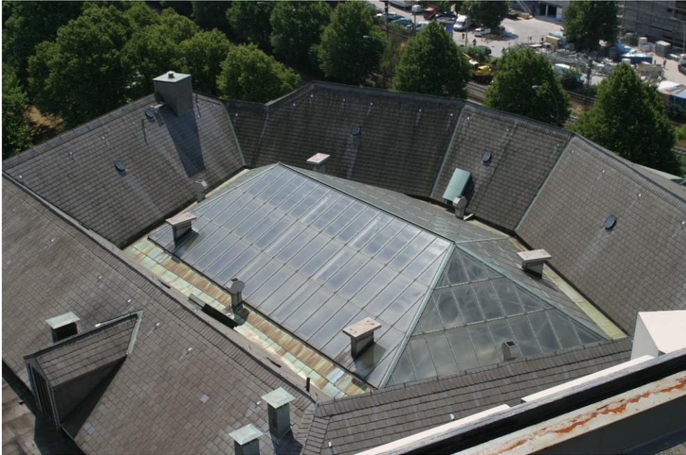
Abb. 59. Das Hauptdach des Altbaus, das von der Bücherturmterrasse aus aufgenommen wurde, besteht an der Peripherie aus einem Schieferdach und in der Mitte (über dem Lichthof) aus einem Glasdach. Zwischen Glasdach und Lichthof befindet sich noch eine Glasdecke (vgl. Abb. 61 und 62). Links unten im Bild ist der Zugang zum Flachdach des Altbau-Magazins zu erkennen. (Foto vom 20.07.2006, Peter Voigt, SUB)
