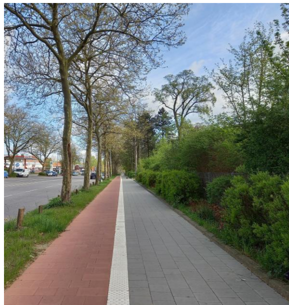
Instandsetzung Gehwege Bargteheider Straße
