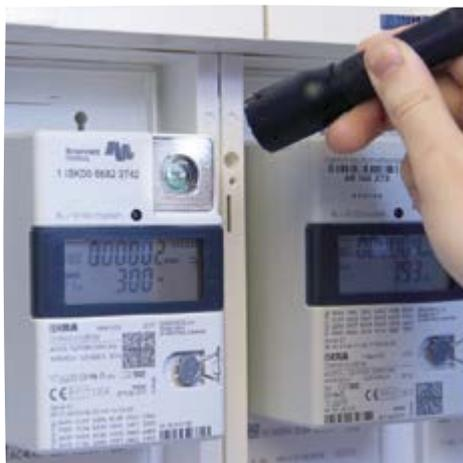
Moderne Messeinrichtungen informieren die Haushalte detailliert über ihren Stromverbrauch. Smart-Meter-Gateways als Teil des intelligenten Stromnetzes ermöglichen perspektivisch eine Steuerung von Erzeugungsanlagen und Verbrauchseinrichtungen.
