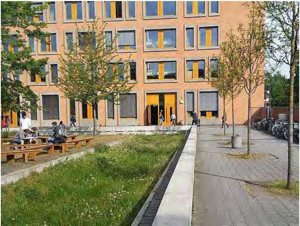
Abb. 11: Beispiel einer Versickerungsmulde (Quelle: Sieker, Die Regenwasserexperten)
