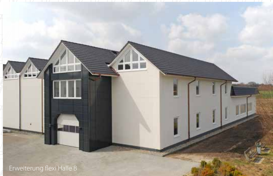
flexi Halle B, erster Bauabschnitt
