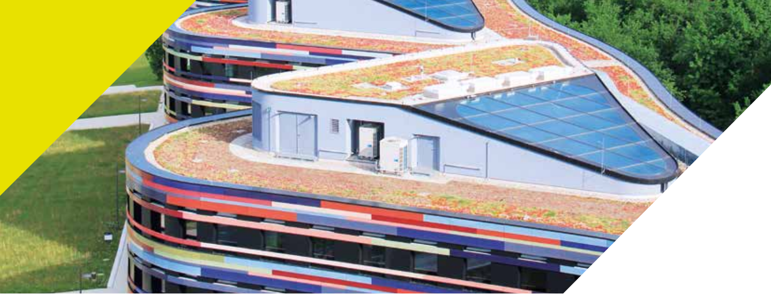
Das extensive Gründach der Behörde für Umwelt, Klima, Energie und Agrarwirtschaft.
