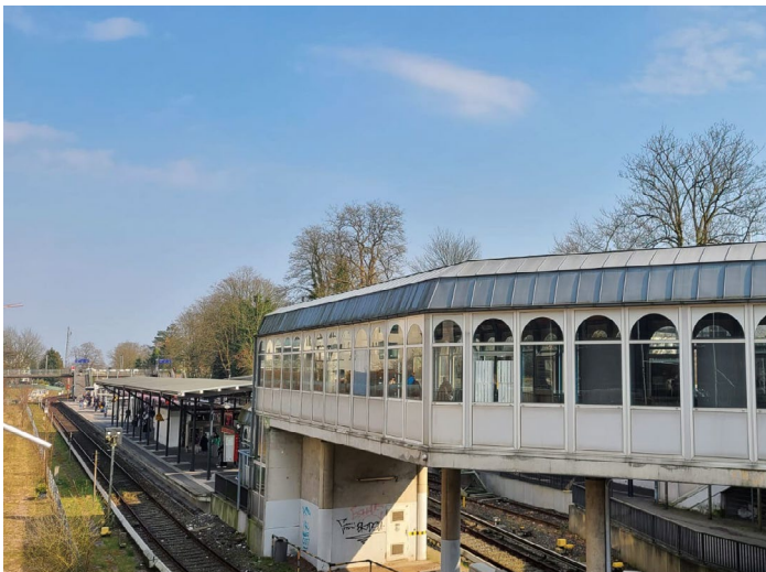
Lärmgedämpfte Maschinen kommen bei den Arbeiten zum Einsatz.
