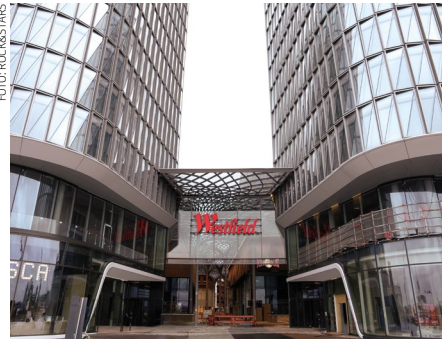
Das neue Herzstück der HafenCity
