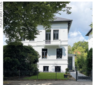
Sanierung bei älteren Häusern lohnt sich.
