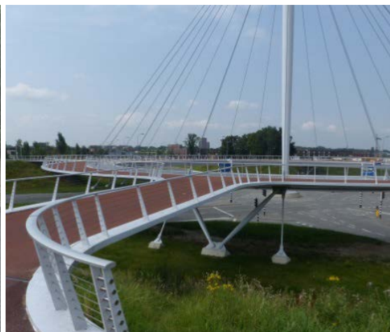
Abb. 2.2 Kreisverkehr für Radverkehr über einem Knotenpunkt in Eindhoven
