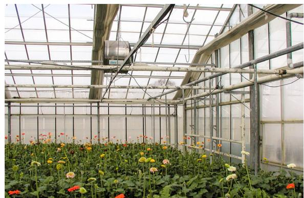
voluminösen Pflanzenteile (Knospen und Blüten) erwärmen sich langsamer als die Luft und es folgt Niederschlag mit nachfolgendem Pilzbefall. Durch richtig eingesetzte Luftbewegung mittels Ventilation erwärmen sich die Pflanzen schneller und Infektionen werden verhindert.
