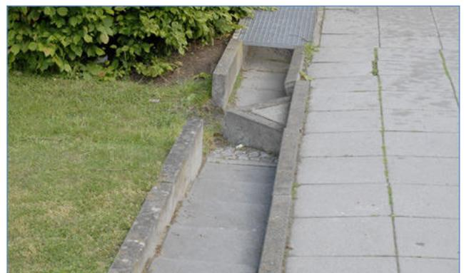
Abb. 10: Entwässerung über eine offene Kastenrinne
