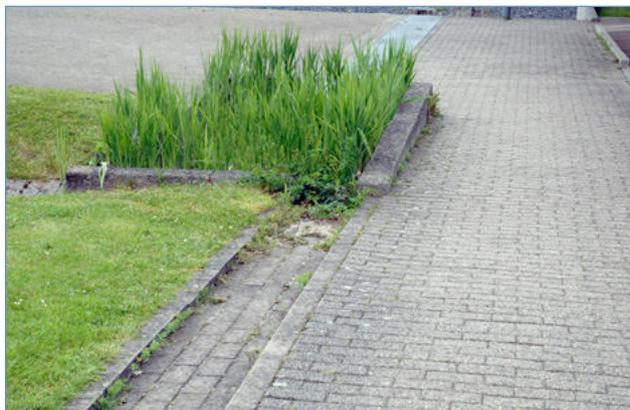
**Abb. 26:** Versickerung über Tiefbeete mit Rigolen im Straßenraum
