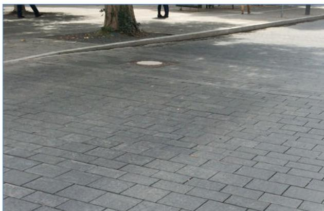
**Abb. 29:** Schaffung von Retentionsraum durch Fahrbahnabsenkung
