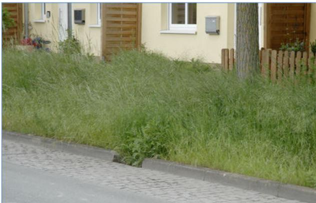
**Abb. 25:** Straßenentwässerung in bepflanzte Versickerungsmulde
