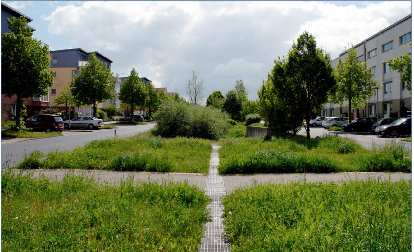
Abb. 30: Großflächige Versickerungsmulden im Mittelstreifen
