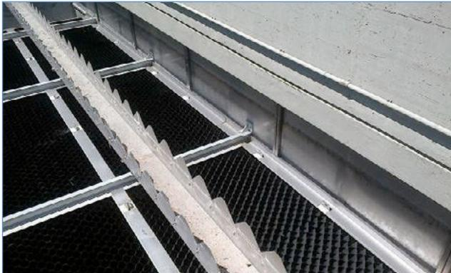
Abb. 32: Lamellenabscheider
