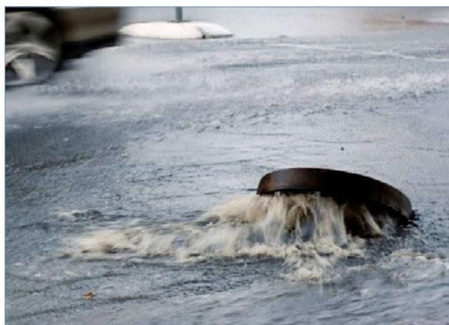
Abb. 4: Sielüberstau als Folge eines Starkregenereignisses
