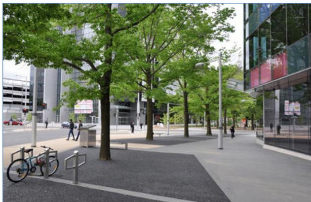
**Abb. 27:** Versickerung über Baumscheiben
