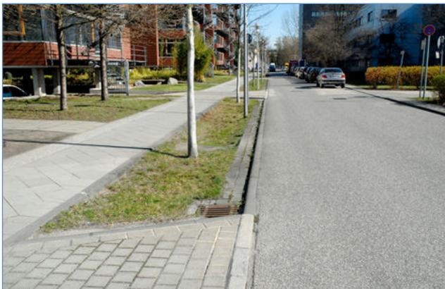
**Abb. 24:** Versickerung der Gehwegabflüsse in Rigolen
