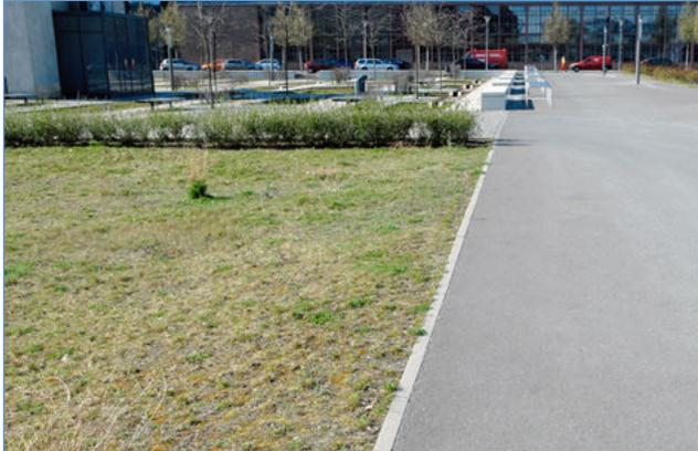
**Abb. 22:** Flächenversickerung durch den bewachsenen Boden
