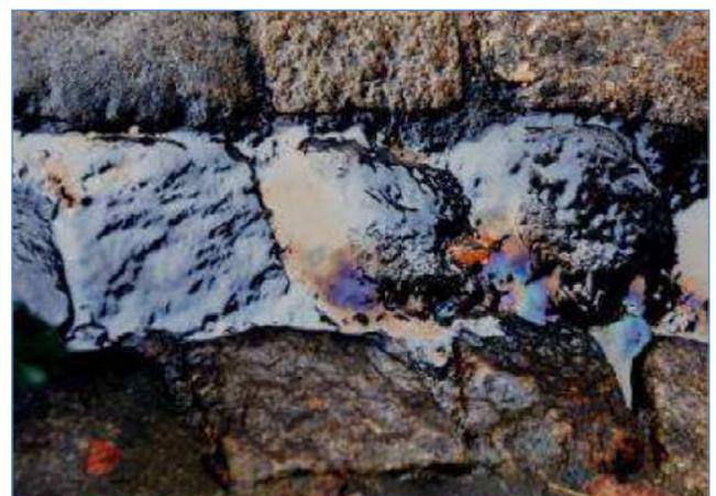
Abb. 3: Schadstofffahne im Straßenabfluss
