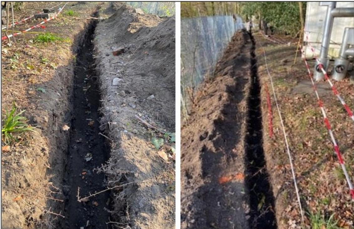
Abb. 32: In dem ca. 30 m langen Wurzelsuchgraben entlang des Grenzzaunes konnten bis in ca. 1 m Tiefe kaum Wurzeln vorgefunden werden (aus der Stellungnahme von [REDACTED] vom 22.08.2022)
