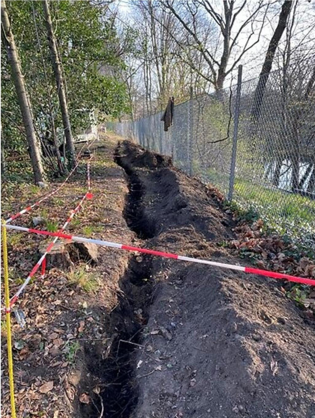
Bild 3 Verlauf Wurzelsuchgrabung von Süden, im Vordergrund alter Baumstubben
