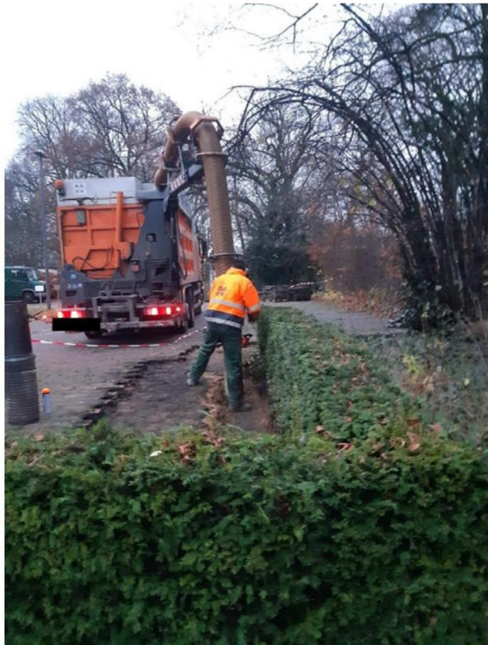
Bild 6, 6.1 Bereich der Wurzelsondierung Linde Nr 1, Saugwagen
