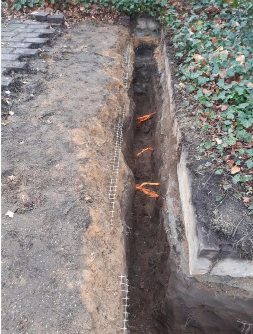
Bild 8 freigelegte Wurzeln im Suchgraben Ost nach West, Wurzelauftreten farbig markiert
