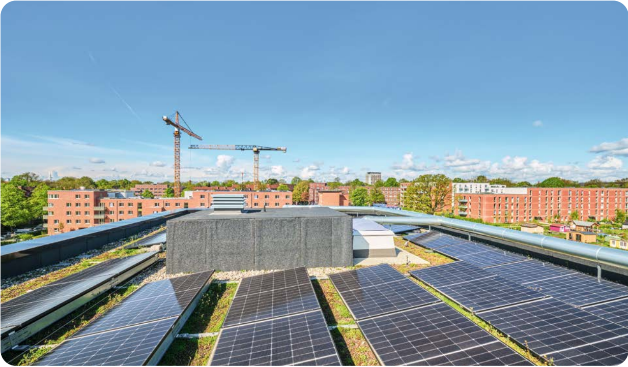
Der Jahresbedarf an Betriebsstrom für die Wärmepumpen im Schlicksweg wird zu 100% mit einer Fotovoltaikanlage produziert.
