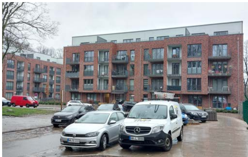
August-Krogmann-Straße 100, SAGA Typenbau Quelle: Bezirksamt Wandsbek
