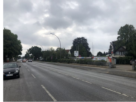
Luruper Hauptstraße, Südseite
