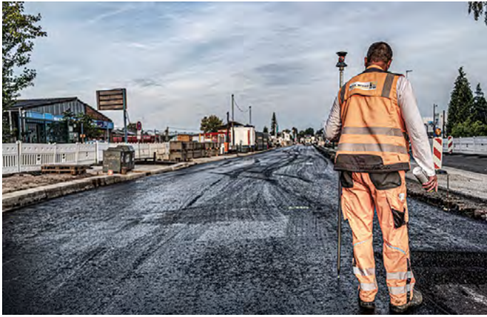
Beim Straßenbau ist die Rezession noch nicht so stark zu spüren. Fotos: Max Wiede GmbH
