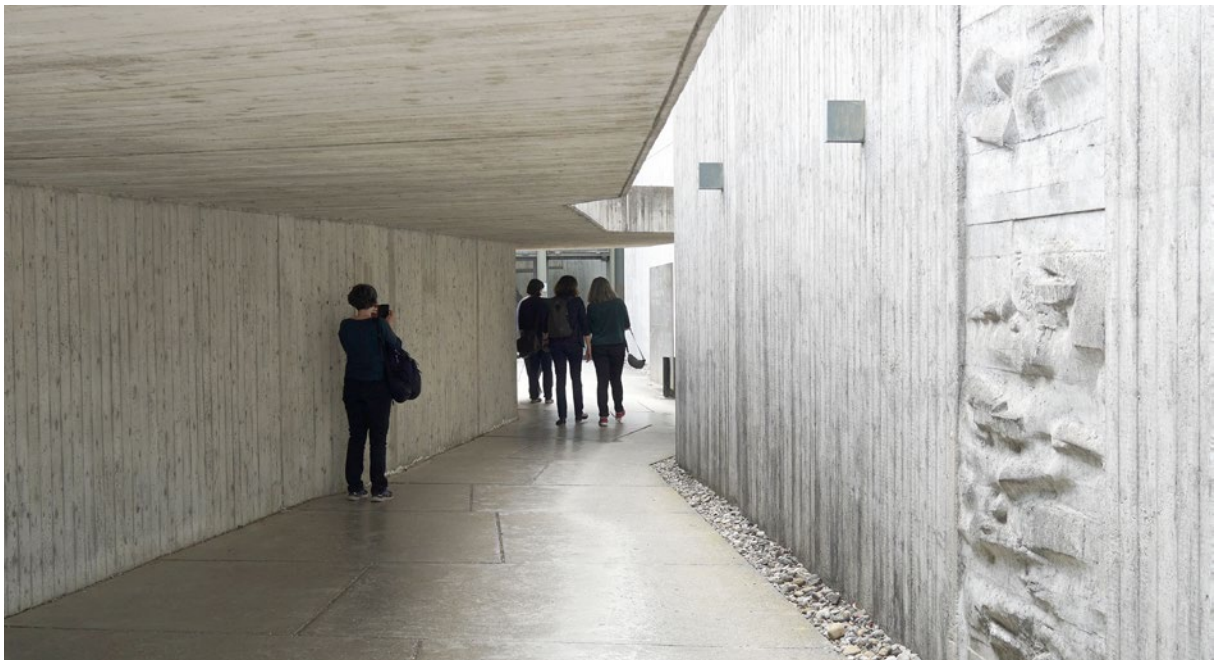
▲ Eingang zur Evangelischen Versöhnungskirche, der zentralen Gedenkstätte der EKD für alle Opfer des Nationalsozialismus. Architekt Helmut Striffler wollte bewußt einen Kontrapunkt setzen zur rechtwinkligen Anlage des KZ
