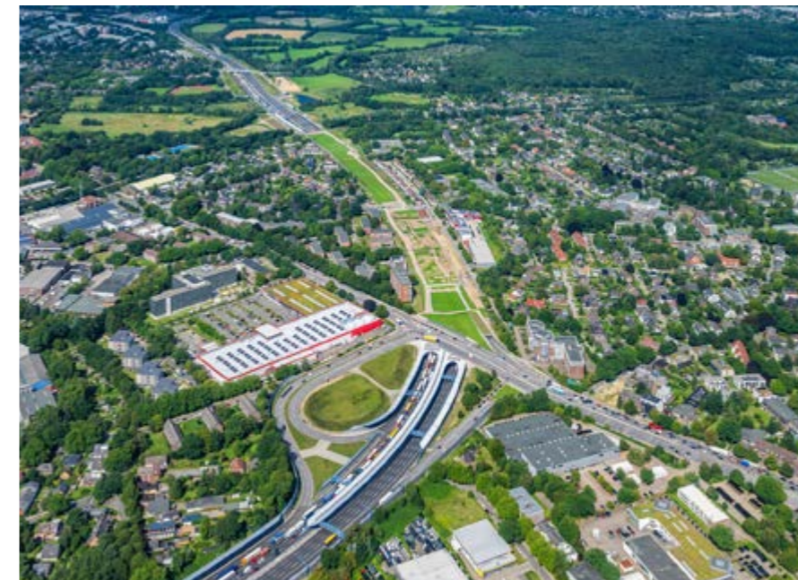
Mehr Ruhe fürs Quartier, mehr Fläche für den Stadtraum: In Stellingen ist die A7 bereits „überdeckelt“
