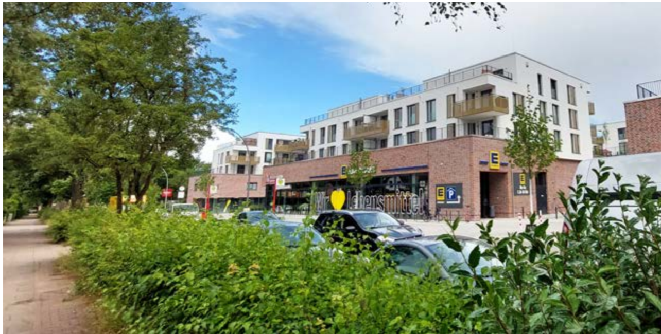
Gut gestapelt: Über dem neuen Nahversorgungszentrum „Meiendorfer Weg“ sind Wohnungen entstanden
