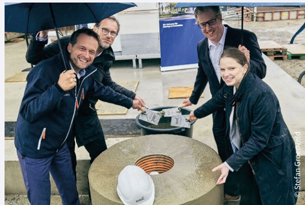
Ließen sich die Freude während der Grundsteinlegung bei bestem Hamburger Sommerwetter nicht verderben: Dr. Rolf Strittmatter, Hamburg Invest, Dr. Andreas Kleinau, HafenCity Hamburg, Björn Oellrich, ADK Modulraum und Wirtschaftssenatorin Dr. Melanie Leonhard (v.l.) starteten symbolischen den Bau des techHub Hamburg.
