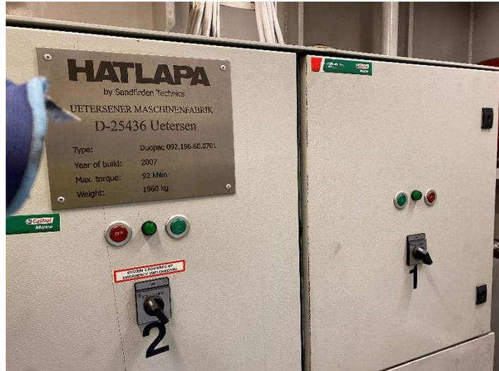
Abbildung 14: Typschild an der Ruderanlage der PAIVI<sup>26</sup>
