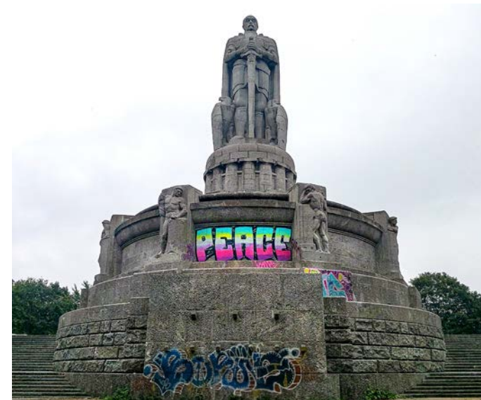
10 Hamburger Bismarckdenkmal kurz nach der Sanierung, 2023
