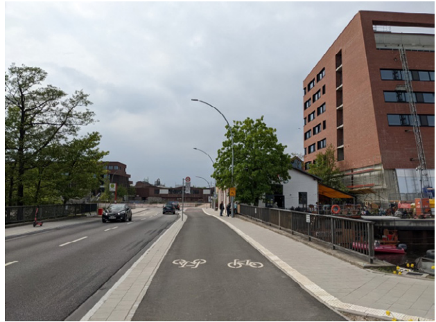
Abb.45: Blick auf die Veloroute 10 an der Straße Kanalplatz.
