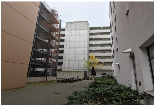
Abb. 32: Innenhof im Quartier Harburger Brücken
