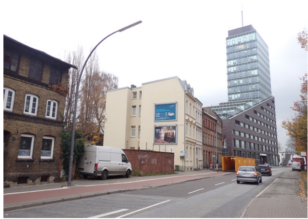
Abb. 9: Maßstabssprung von historischen zu modernen Gebäuden (Blick von der Straße Karnapp)
