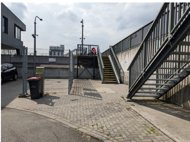
Abb.37: Schleusenquerung im nördlichen Binnenhafen
