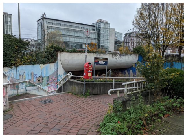
Abb. 38: Blick auf die Rampe Tunnel Neue Straße
