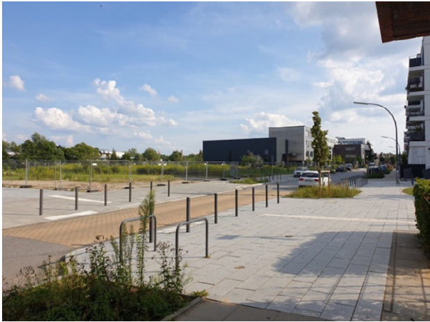
Abb.44: Querungshilfe über die Theodor-Yorck-Straße im Anschluss an den Harburger Brücken Grünzug (Foto BA Harburg, Hr. Dreher)
