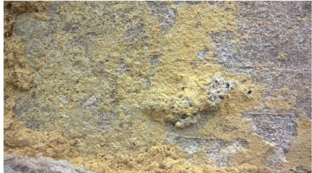
Abb. 2 Sondierungspunkt mit bauzeitlichem Putz auf Kohlesandsteinoberfläche
