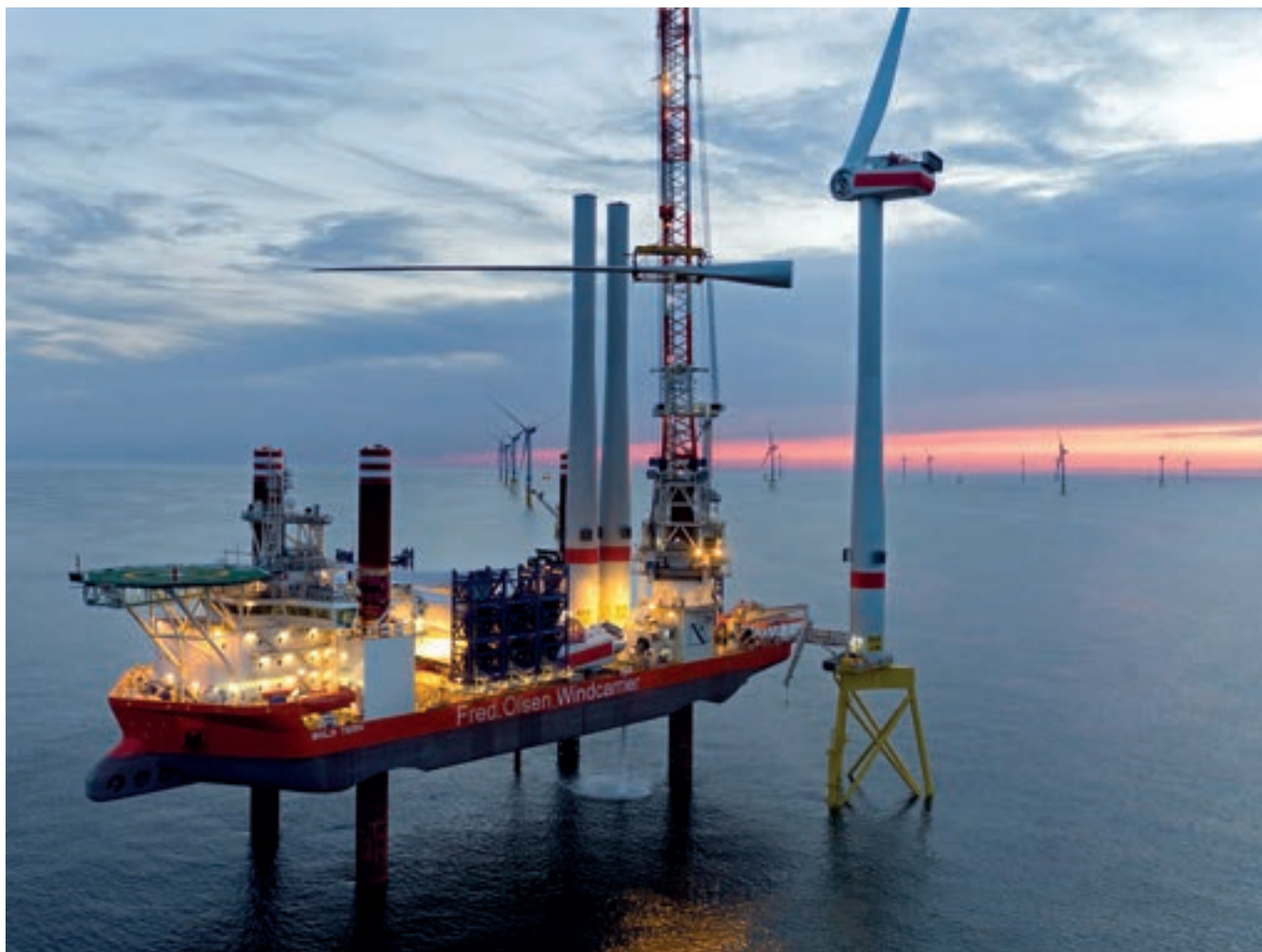
Installation einer Windkraftanlage im Windpark Borkum Riffgrund 2
