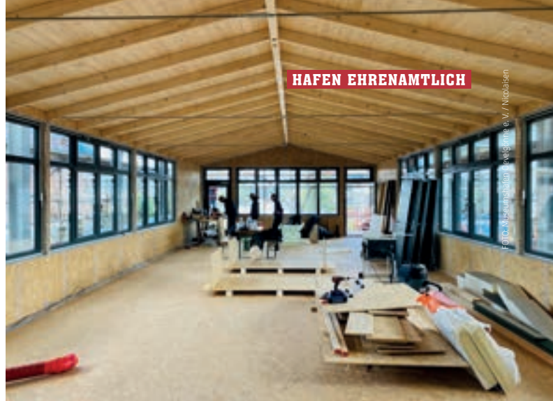
Der zukünftige Besucherraum nimmt langsam Formen an.
