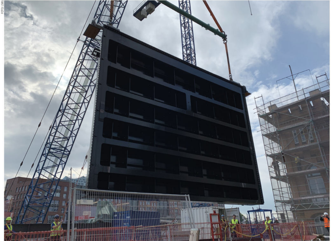
Tonnenschweres Sperrwerktor am Haken
