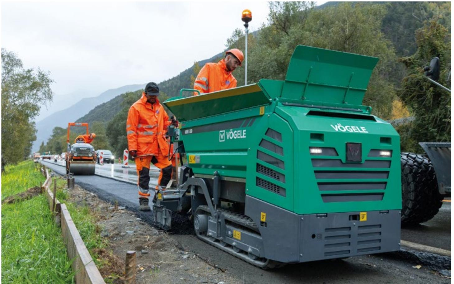
Ideal für schmale Einbaumaßnahmen auf engem Raum: Der MINI 500 ist sehr kompakt und bietet Einbaubreiten von nur 0,25 bis 1,8 m.
