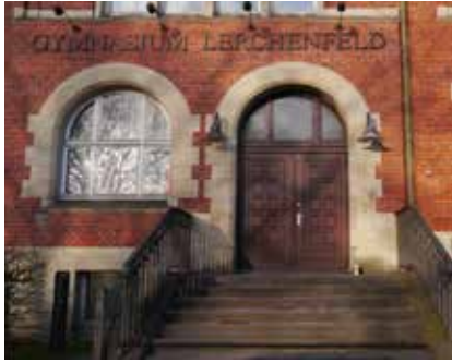
Eingangsportal der Schule
