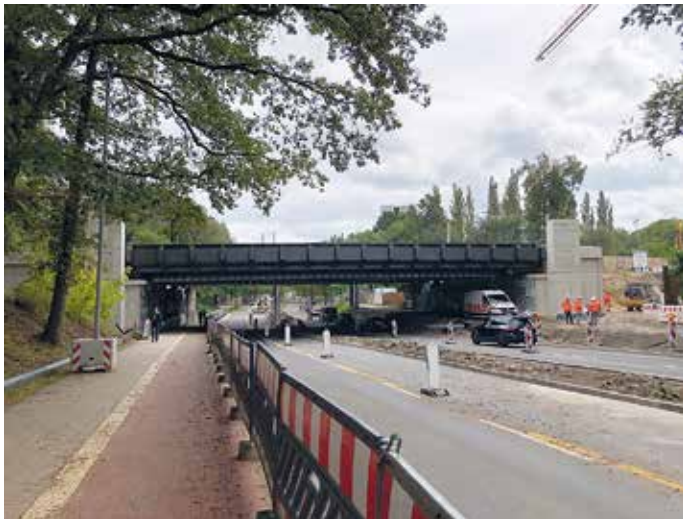
Die neuen Brücken über die Sengelmannstraße, vorn die der U1 Foto: Rainer Cordes
