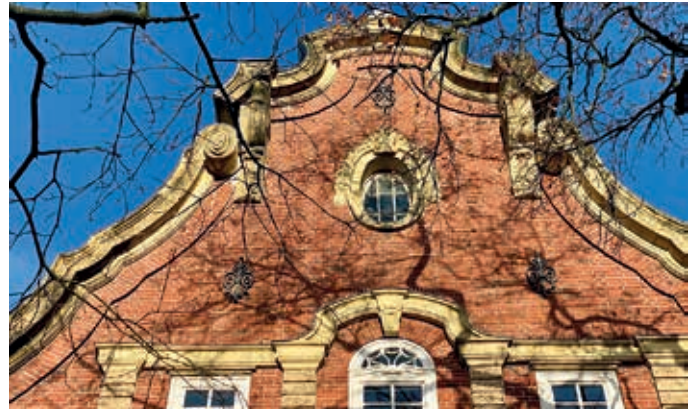
Die dekorativen Maueranker des denkmalgeschützten Rathauses sind nur im Winter gut sichtbar, wenn die Bäume kein Laub tragen. Foto: Rüdiger Steiding
