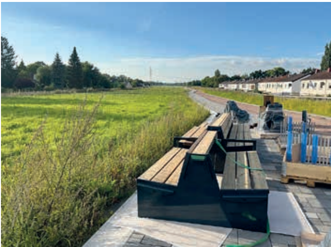
Blick auf den nördlichen Teil des Autobahndeckels.
