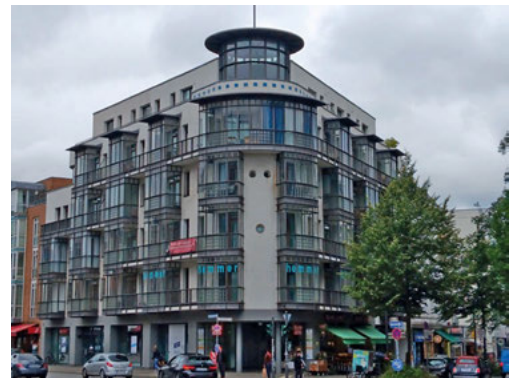
Früheres Shell-Gebäude in der City Nord (unten).
