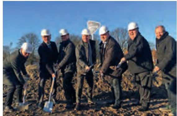
Erster Spatenstich der Handball-Judohalle
