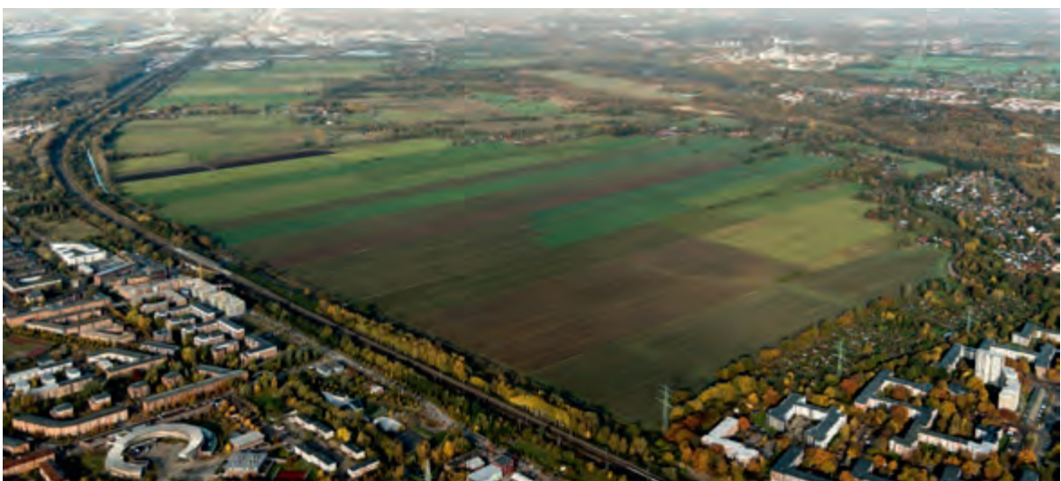
Luftbild des Planungsgebiets für den neuen Stadtteil Oberbillwerder
