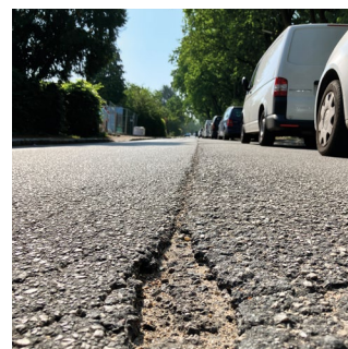
Fahrbahndecke am Sülldorfer Kirchenweg wird endlich erneuert.
