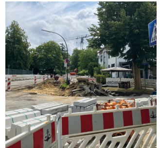
An der Schenefelder Landstraße entstehen zwei neue Bushaltestellen.
