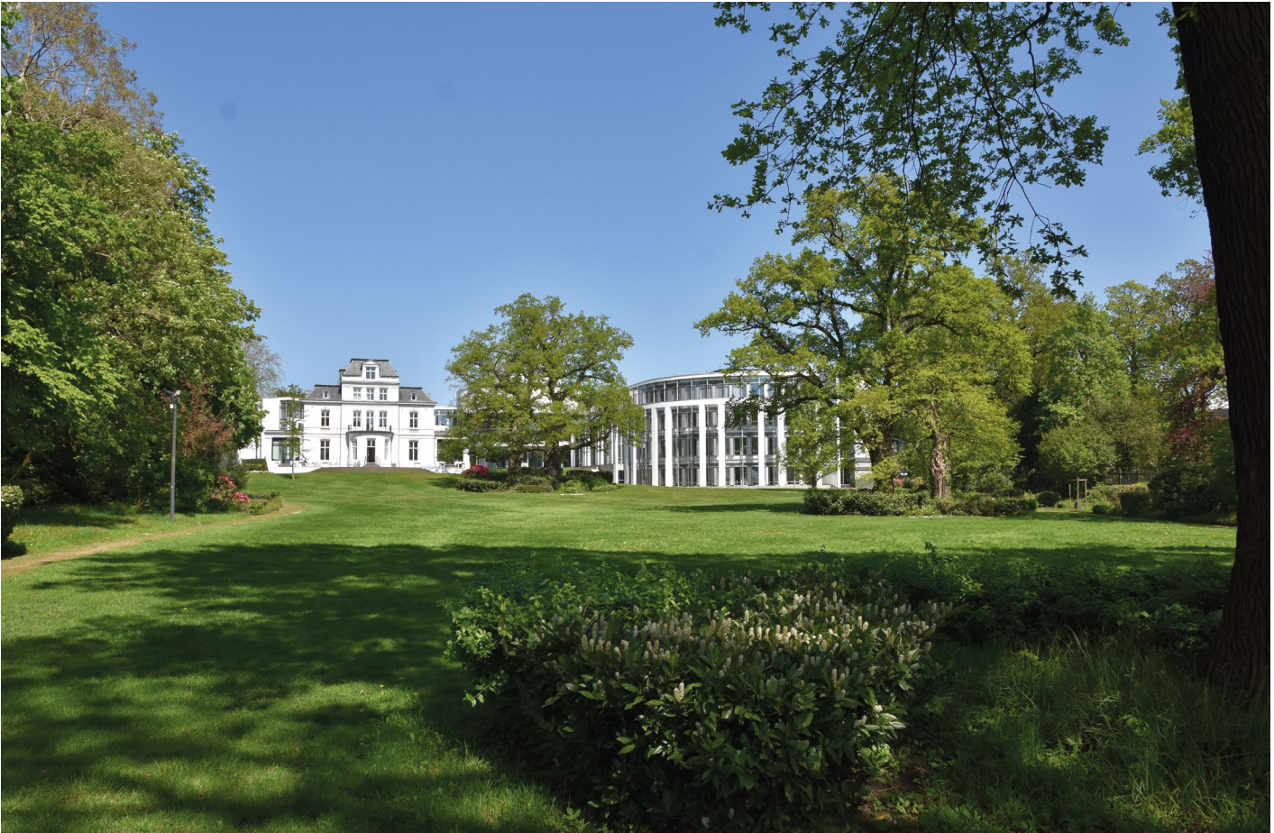
Sicht von der Elbe, links die Schröder'sche Villa, die in das Ensemble integriert wurde.
