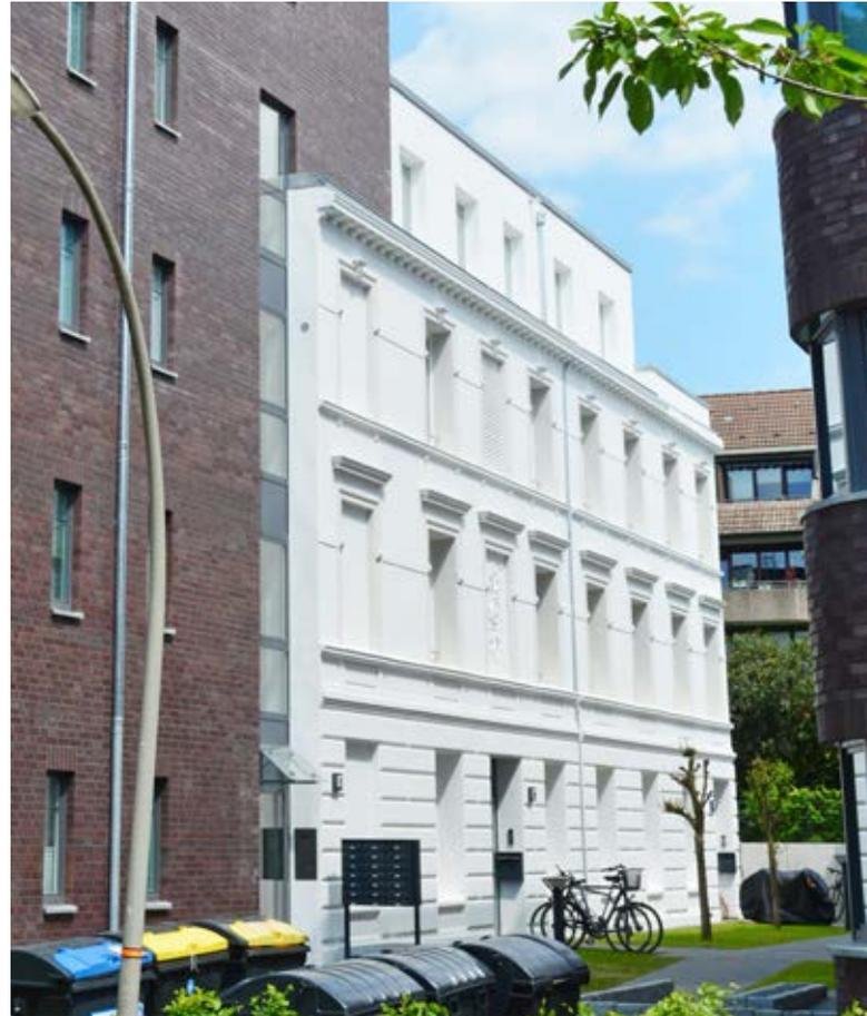
Eine Besonderheit dieses Projektes: Über 60 Meter der historischen Fassaden der ursprünglichen Bestandsimmobilie galt es zu erhalten und in das neue Gebäude zu integrieren. Während der Abbruch- und Bauarbeiten haben wir diese mithilfe eines aufwendigen Traggerüstes gesichert und schließlich in die neuen Fassaden eingebunden.
