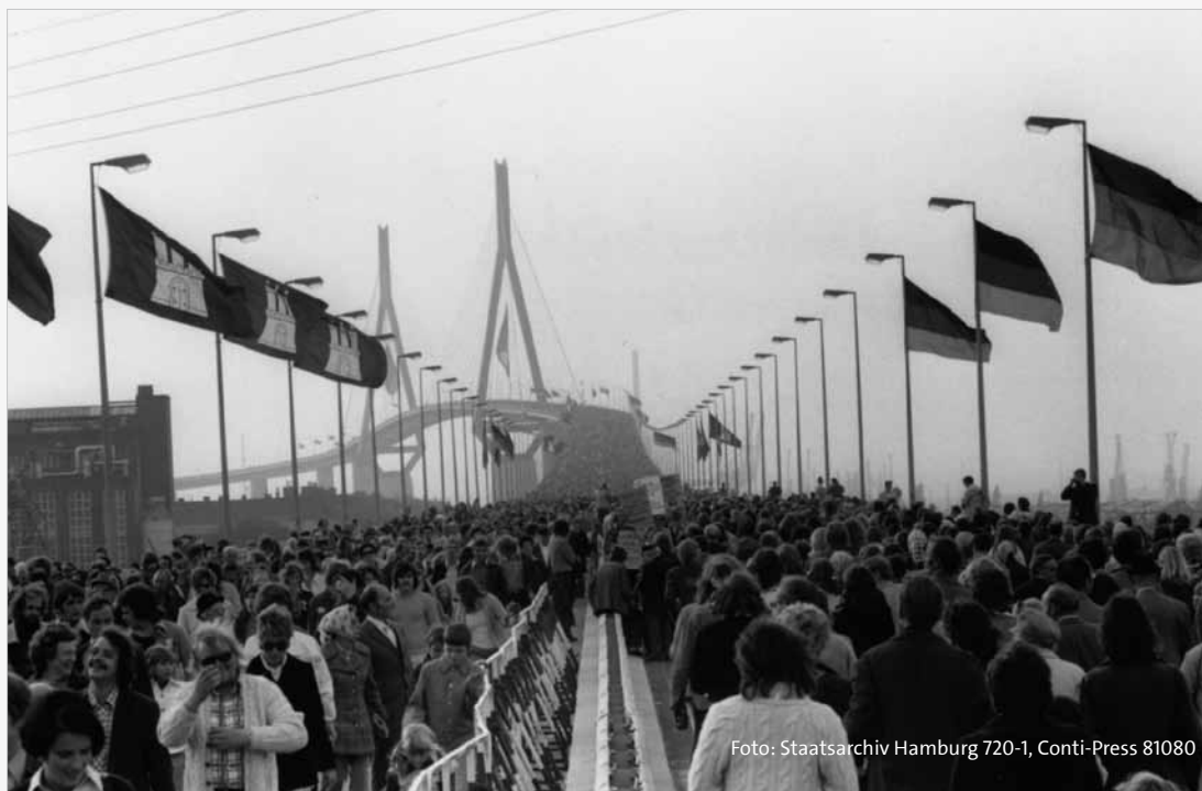
Teil des kollektiven Gedächtnisses Hamburgs: Die Einweihung der Köhlbrandbrücke am 20. September 1974
