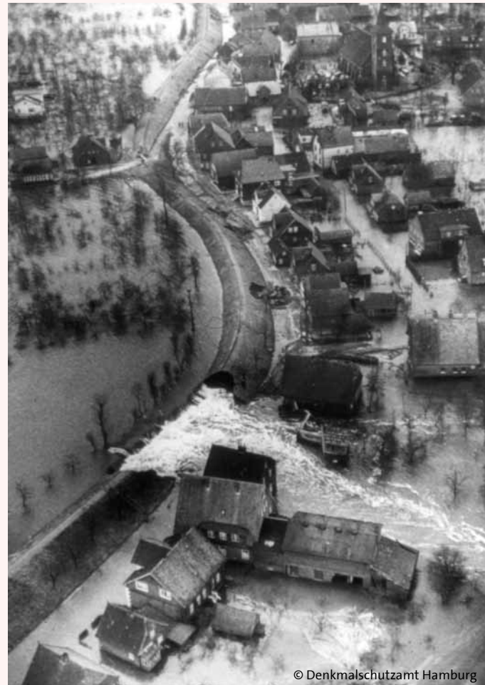
Deichbruch bei Neuenfelde
