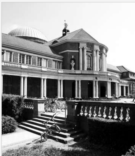
Hauptgebäude Edmund-Siemers- Allee 1
