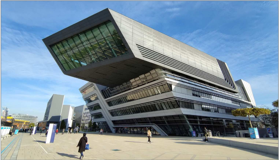
Abb. 3: Außenansicht Library & Learning Center der WU Wien. Foto: Gemeinsame Baukommission von dbv und VDB
