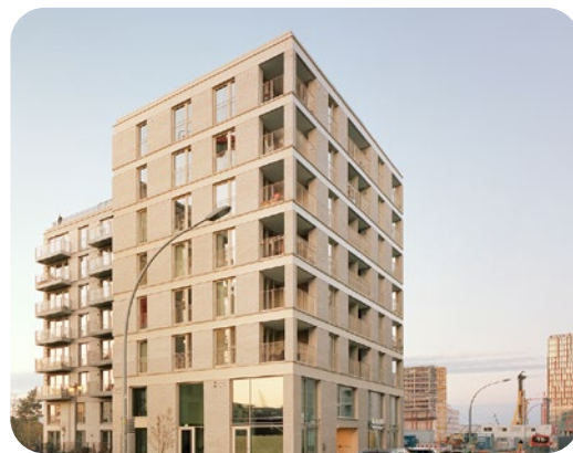
Fertiggestellter Neubau an der Baakenallee 39
