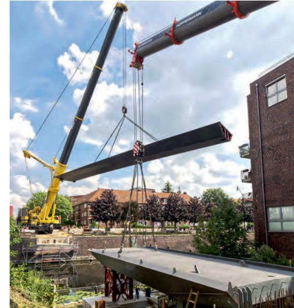
Einhub der Stahlteile für die Maurienbrücke
