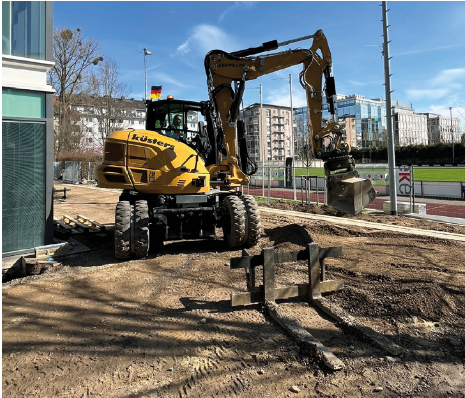
Aktuell läuft der ZM110 auf einer Baustelle in Düsseldorf-Derendorf, auf der 170 Eigentumswohnungen entstehen. (Foto: Zeppelin Baumaschinen GmbH)
