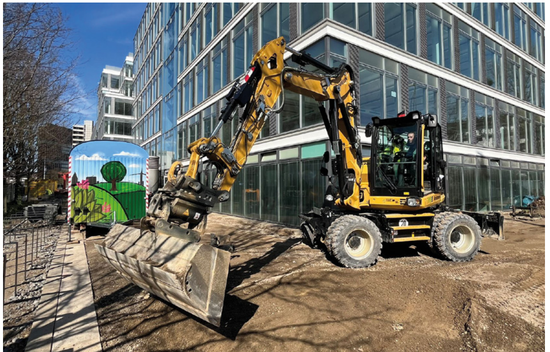
Fahrer Patrick Stähler nutzt sein Arbeitsgerät nicht nur für den Aushub oder um Material zu verladen, sondern auch um Flächen glatt zu ziehen. (Foto: Zeppelin Baumaschinen GmbH)
