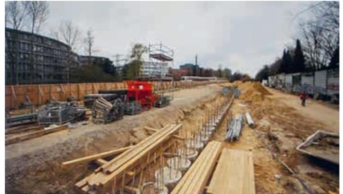
Auch die Vorbereitungen für den in offener Bauweise zu errichtendem Tunnel bis zur Haltestelle City Nord (Stadtpark) laufen bereits. Die Betonpfähle mit dem herausragenden Bewehrungsstahl zeigen den sich absenkenden Verlauf des U 5-Gleises in Richtung City Nord unter der U1 und der Güterumgebungsbahn hindurch, das etwa in Höhe des Gerüsts nach links schwenkt. Rechts, wo die Person steht, liegt zukünftig das Gleis der U 1 stadteinwärts.
